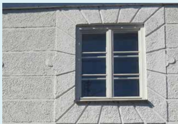
Fenster mit Einfassung im Bossenmauerwerk
