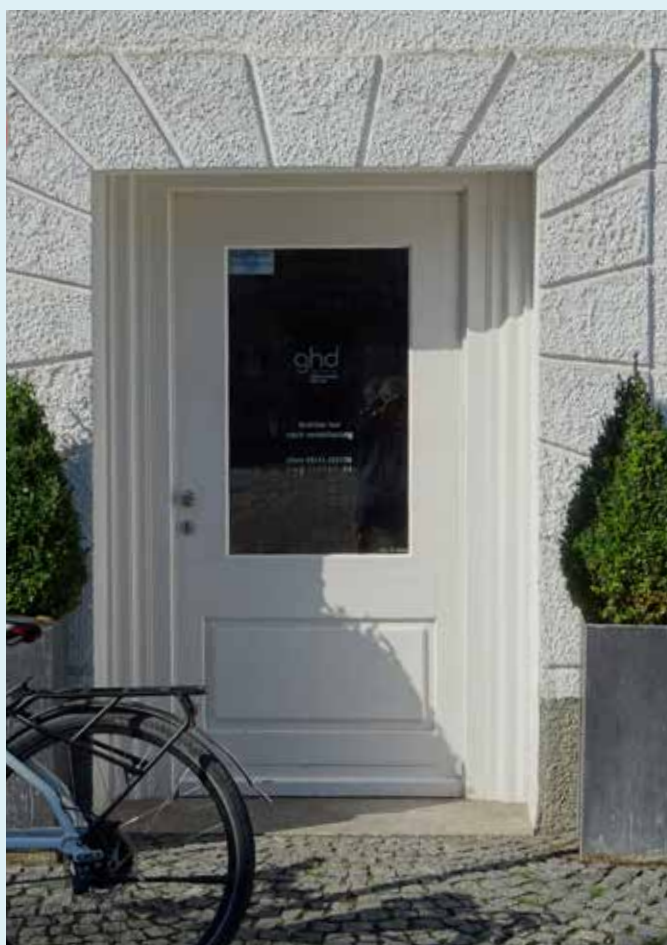
Schlichte Eingangstür, an Fassadenstil angepasst
