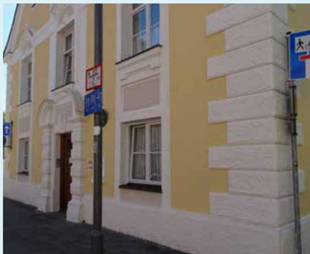
Beispiel für eine Fassade mit Bossenmauerwerk
