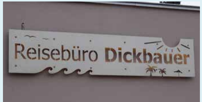
Blechschild mit dahinterliegender indirekter Beleuchtung
