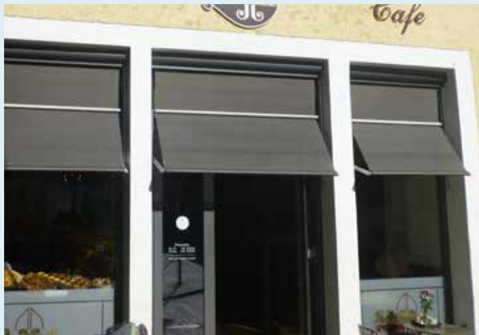
Unauffällig in der Laibung angebrachte Markise
