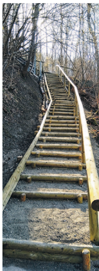
Die instandgesetzte Treppe. Danke an die Bauhofkollegen.
