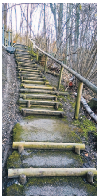
So sah die Treppe vorher aus.
