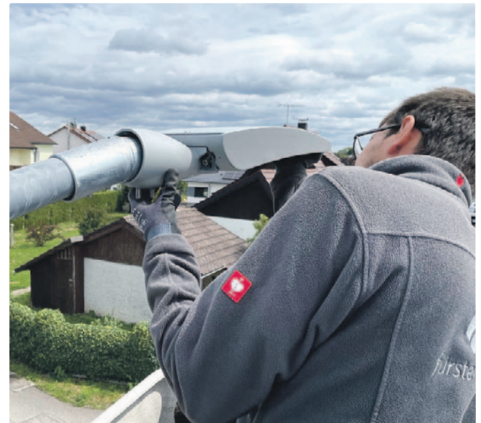
Bild: © Stadtwerke Fürstenfeldbruck – Ein Stadtwerke-Mitarbeiter rüstet eine Straßenlampe auf moderne LED-Technik um
