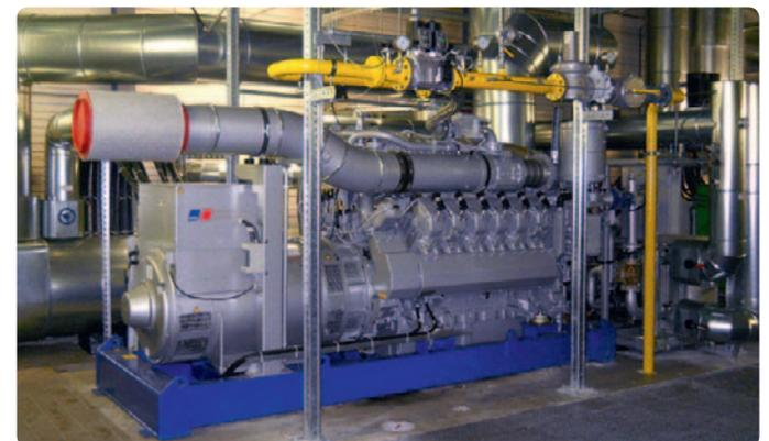
Bild: © Stadtwerke Fürstenfeldbruck – Das Modul 3 des BHKW ‚Auf der Lände‘ wird generalüberholt
