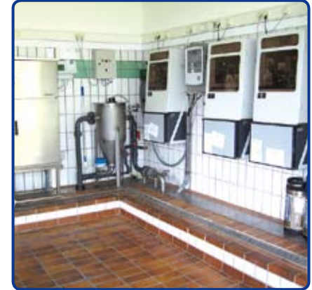
Online-Messgeräte der Auslaufmesstation
