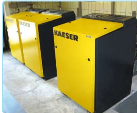
Belüftungsstation für Sandfang und Verteilergerinne Vorklärung
