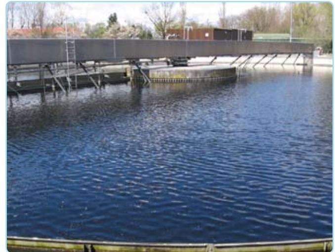
Nachklärung, Volumen 2 \times 5510 \text{ m}^3
