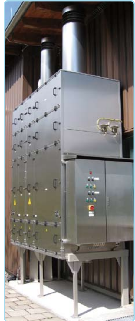
Rechengebäude mit Luftreinigung
